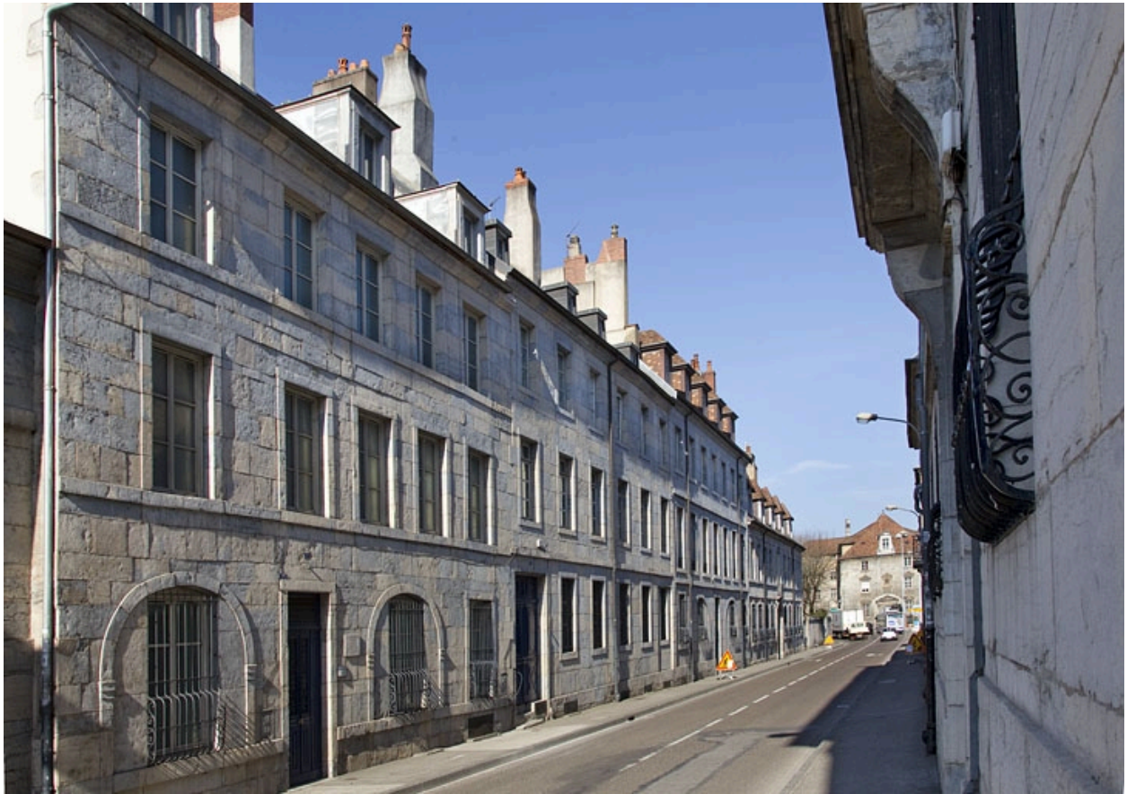
Vue d'ensemble dans l'alignement de la rue, de trois quarts gauche.
