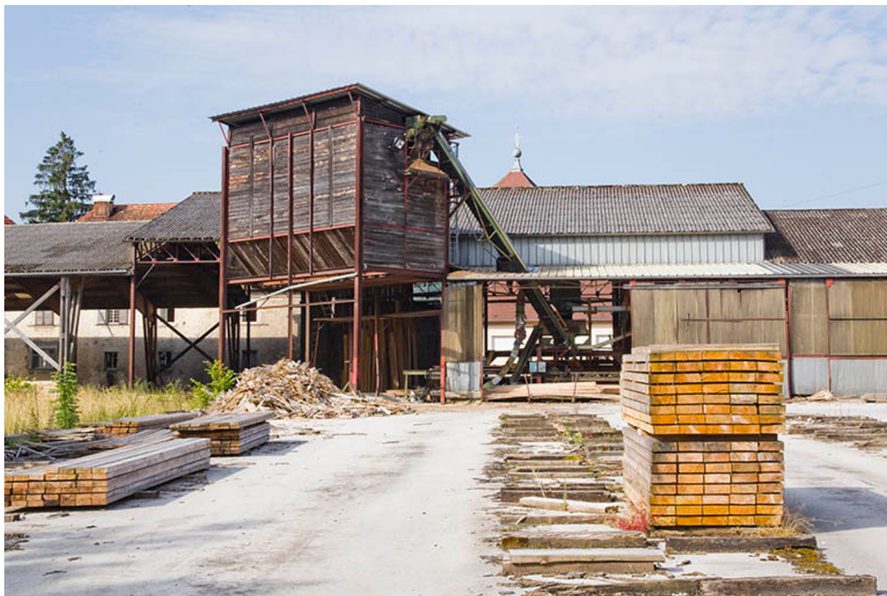
Silo à sciure et hangar de 1969-1970.
