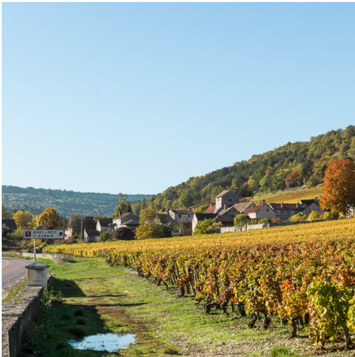
Eglise d'Auxey-Le-Petit dans son site.
