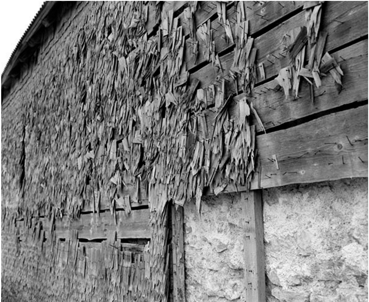
Façade latérale droite en 1978. Elle est protégée par un essentage de bardeaux cloués.
