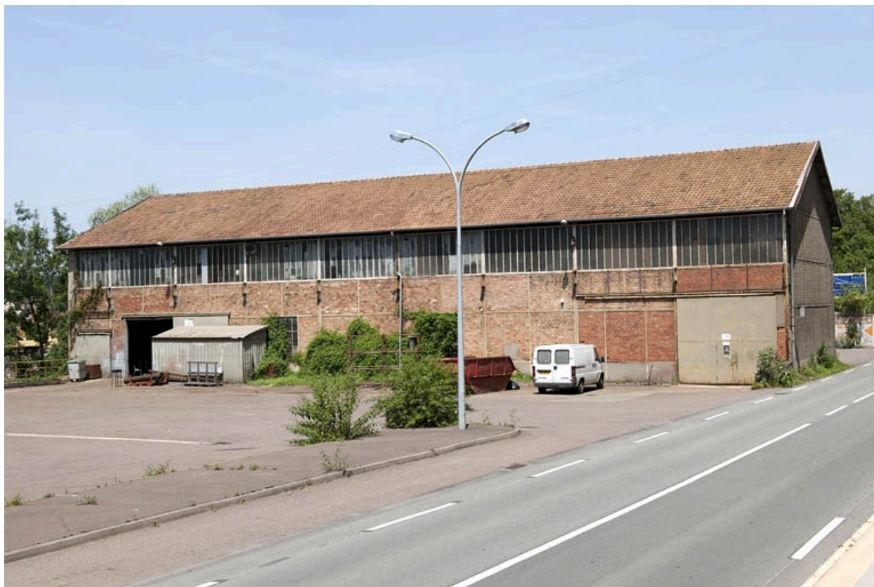
Magasin industriel. Vue depuis l'ouest.
