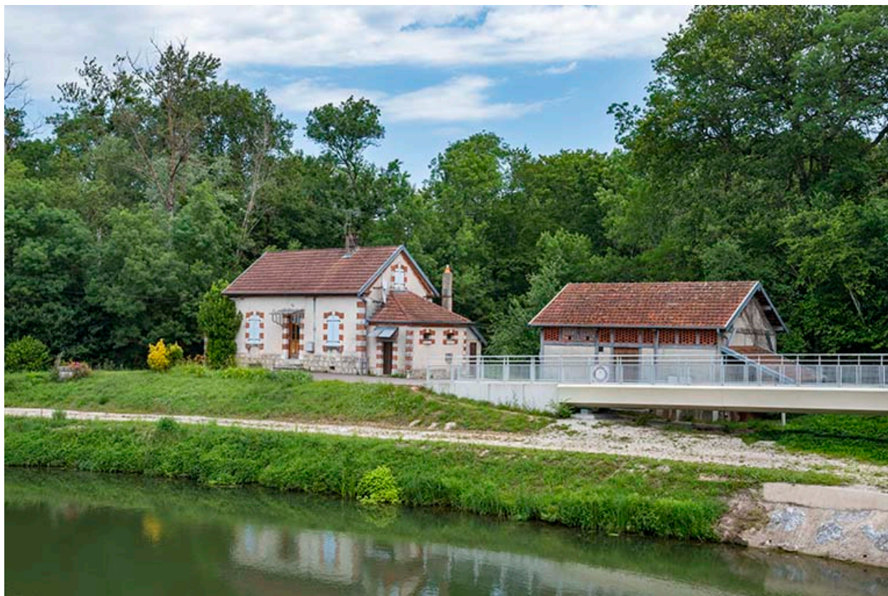
Maison du barragiste à Apremont (70).
