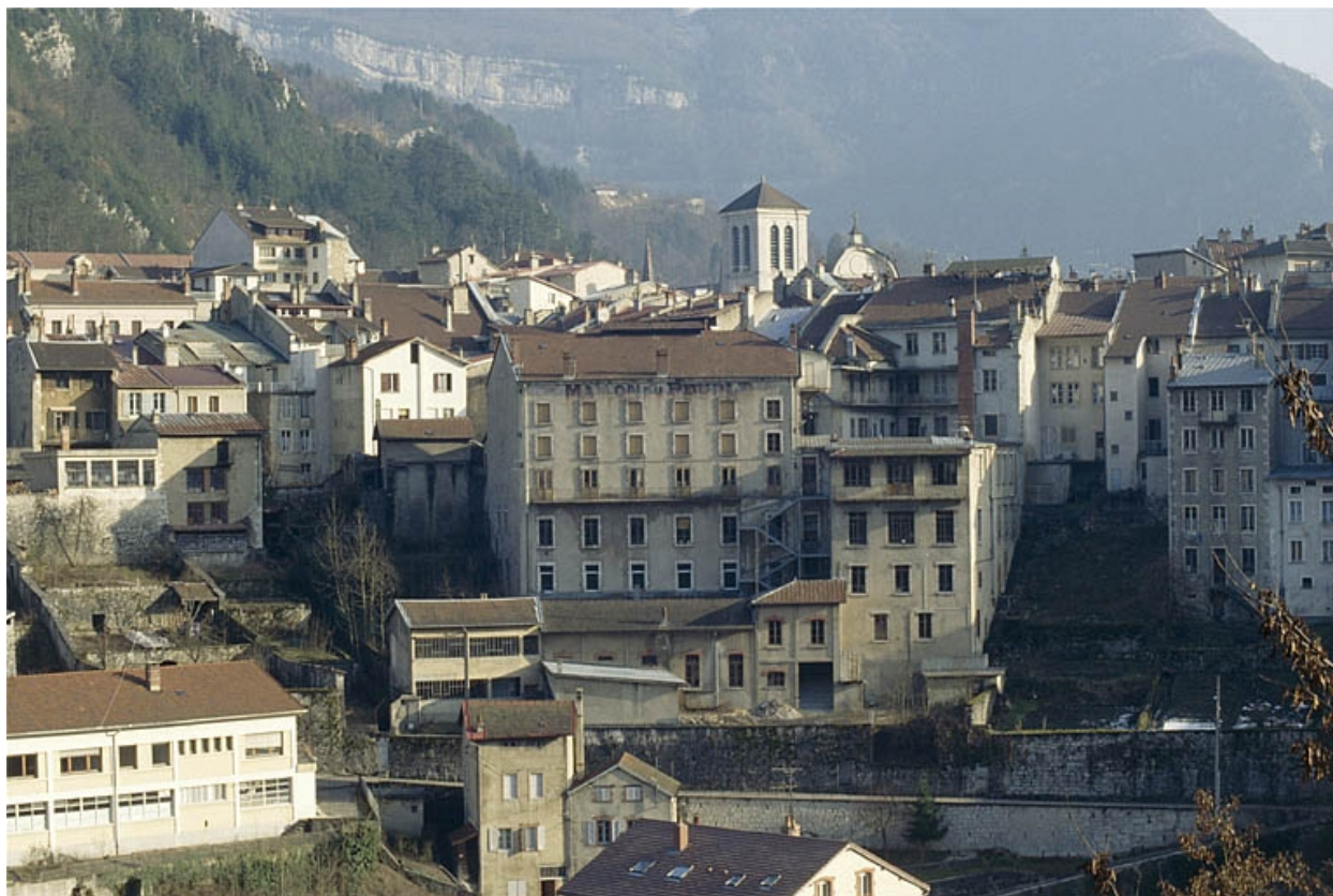
Façades sur la Bienne.
