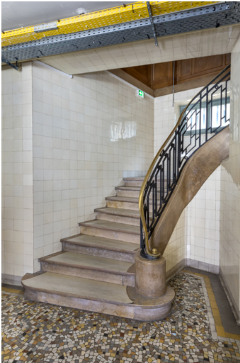
Escalier d'accès au vestiaire (au sous-sol).
