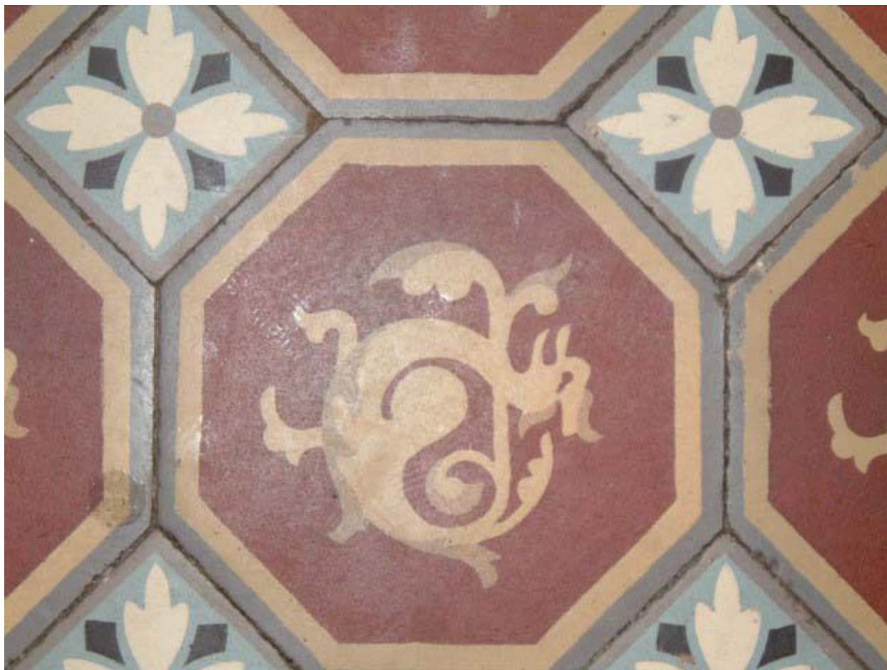
Vue de détail du carrelage du rez-de-chaussée.
