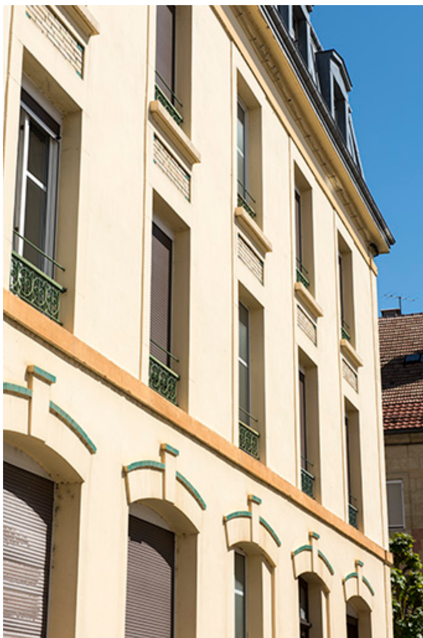
Façade latérale gauche : détail des baies.
