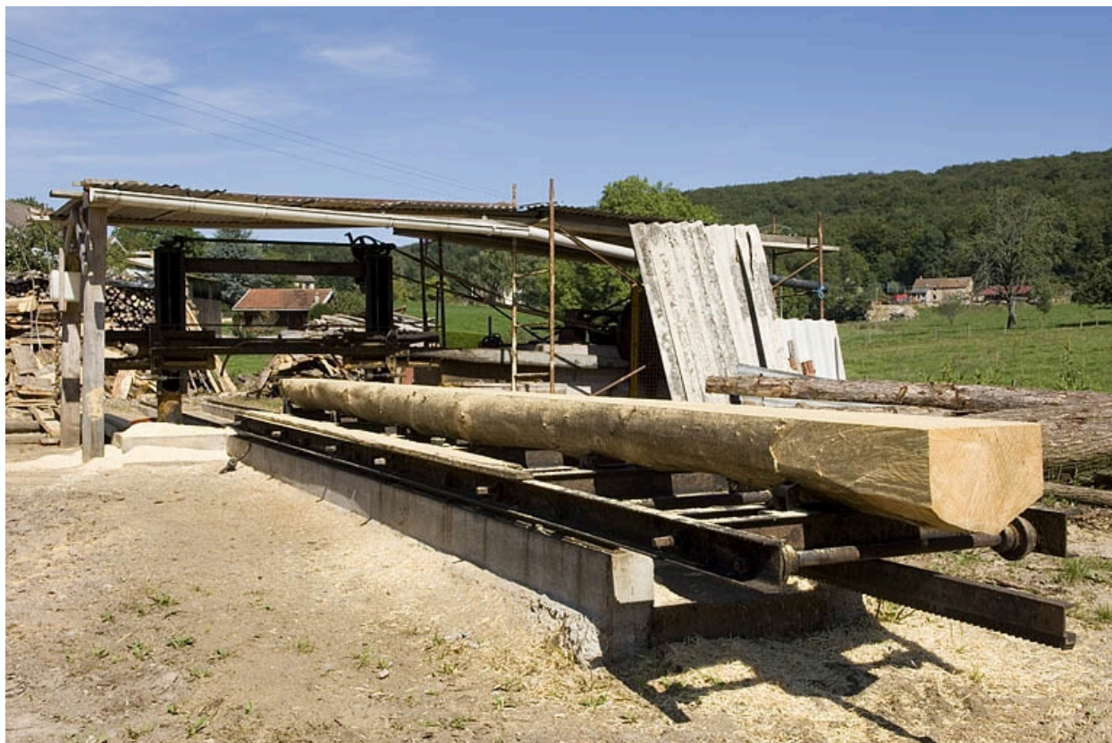
Moulin à farine puis scierie, Ailevillers-et-Lyaumont (hameau de la Louvière) : châssis de scie monolame horizontale.
