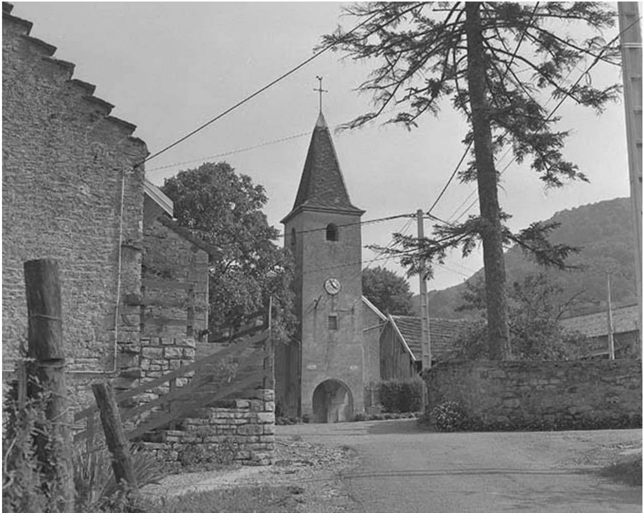
Extérieur : façade antérieure.
