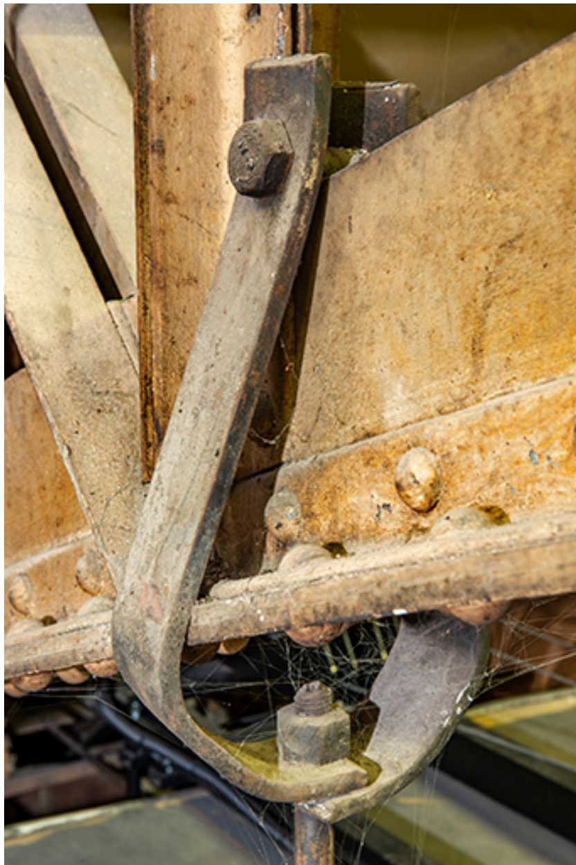
Charpente métallique au-dessus des gradins, étrier de fixation des passerelles.
