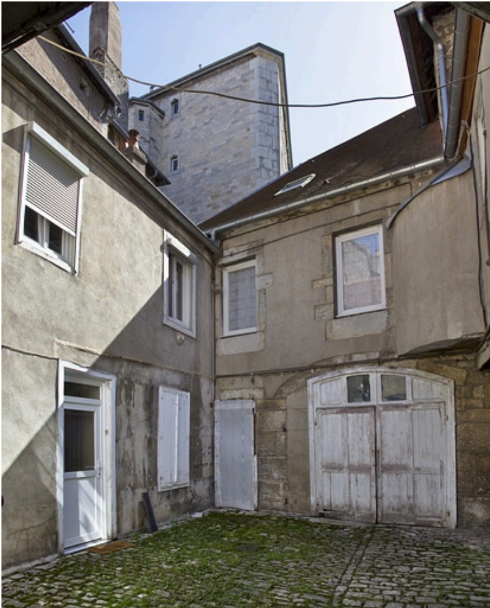
Vue d'ensemble de la deuxième cour, depuis l'entrée.
