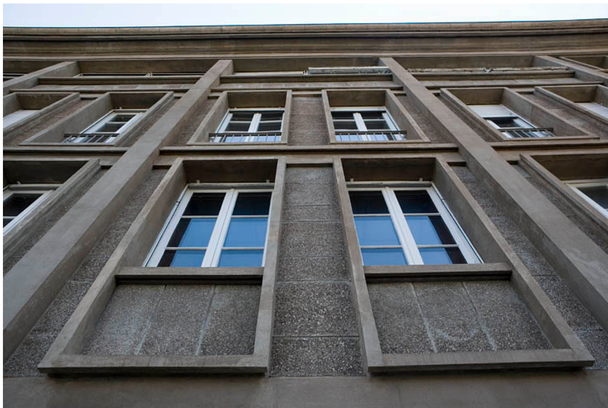
Face latérale droite : fenêtres vues en contre-plongée.
