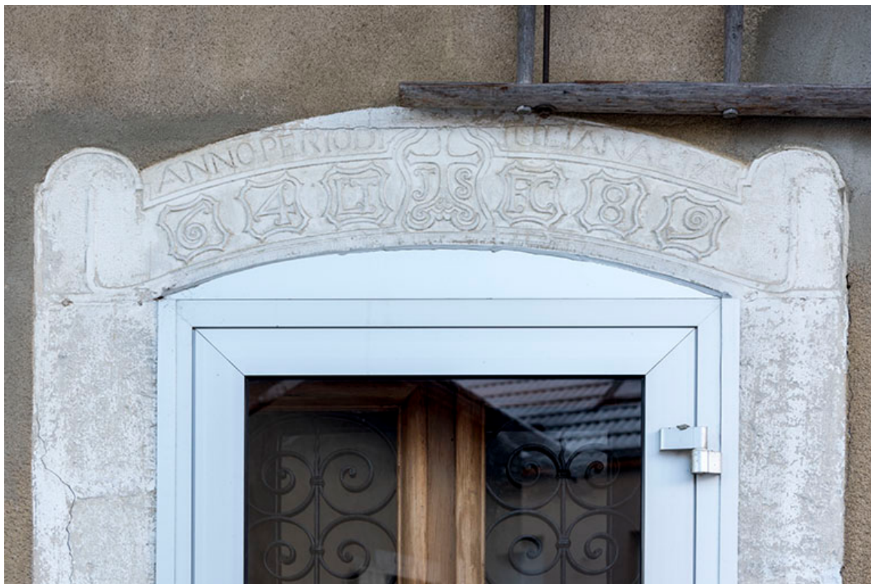
Façade antérieure : linteau avec inscription et datation.
