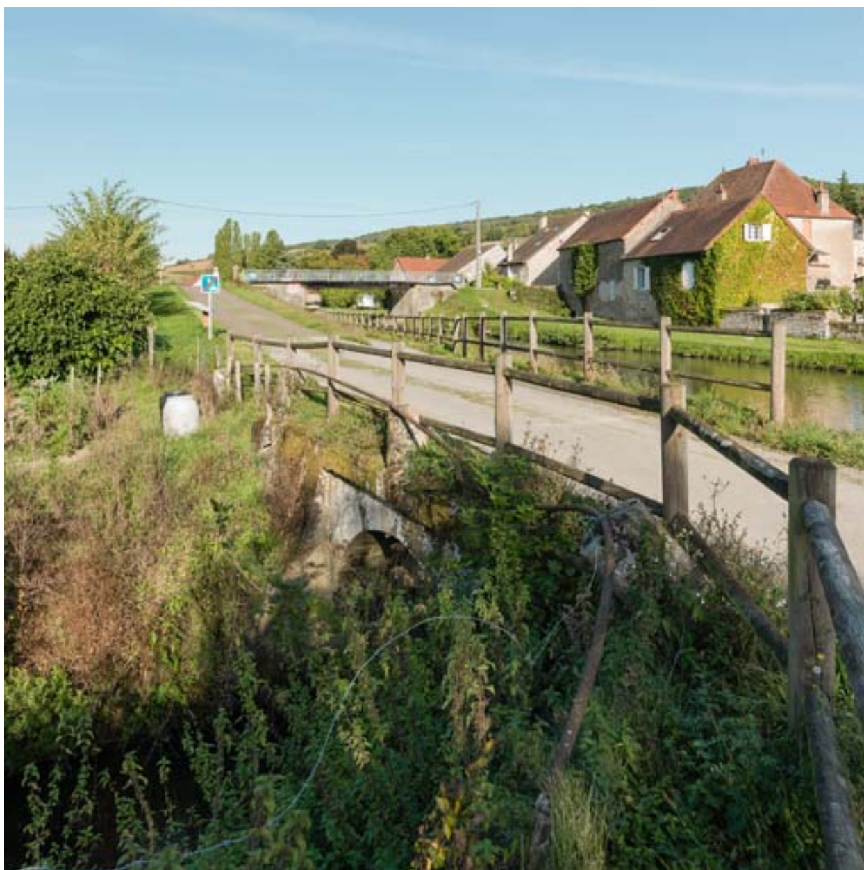
Vue de l'aqueduc.
