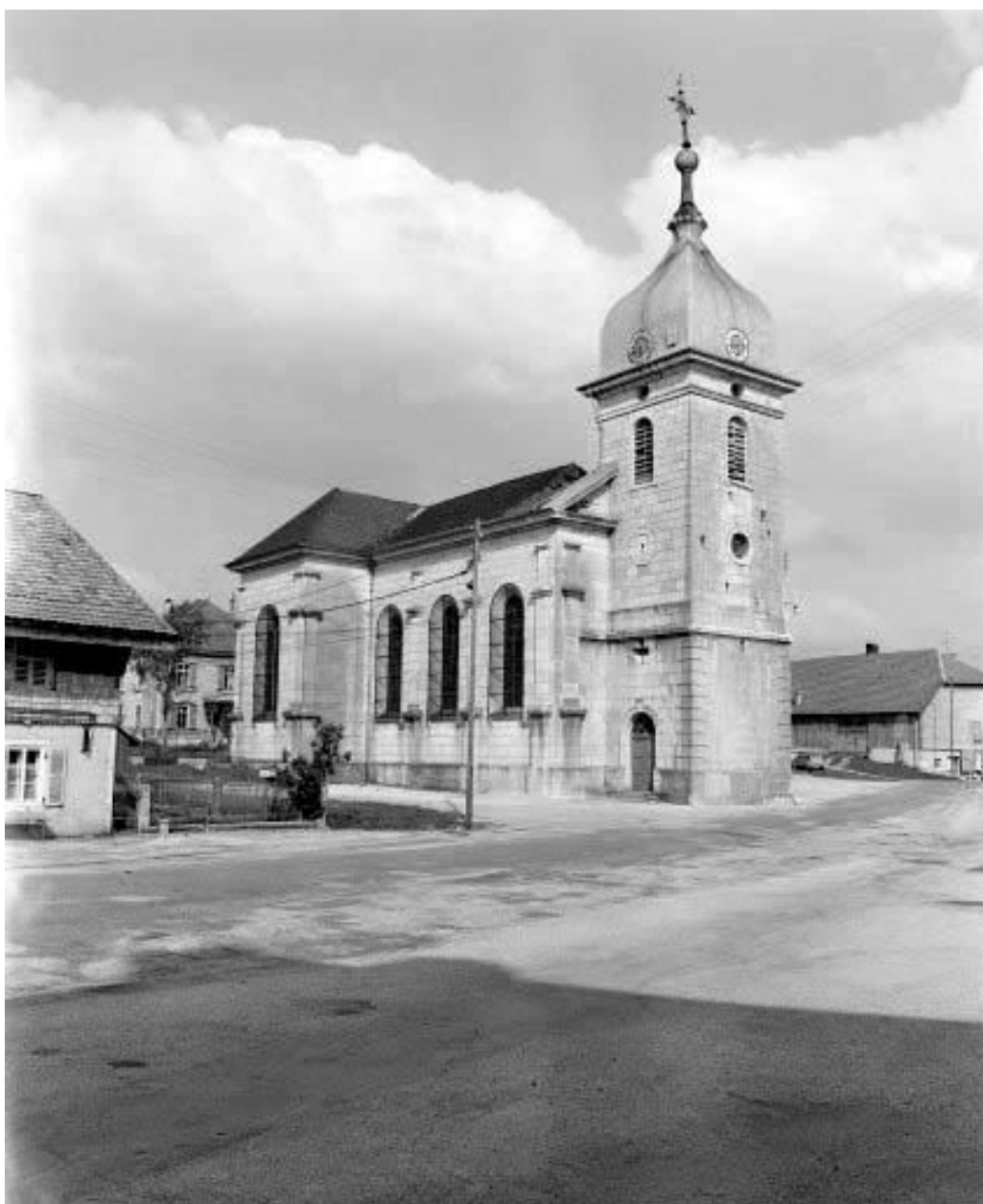
Façades antérieure et latérale gauche.
