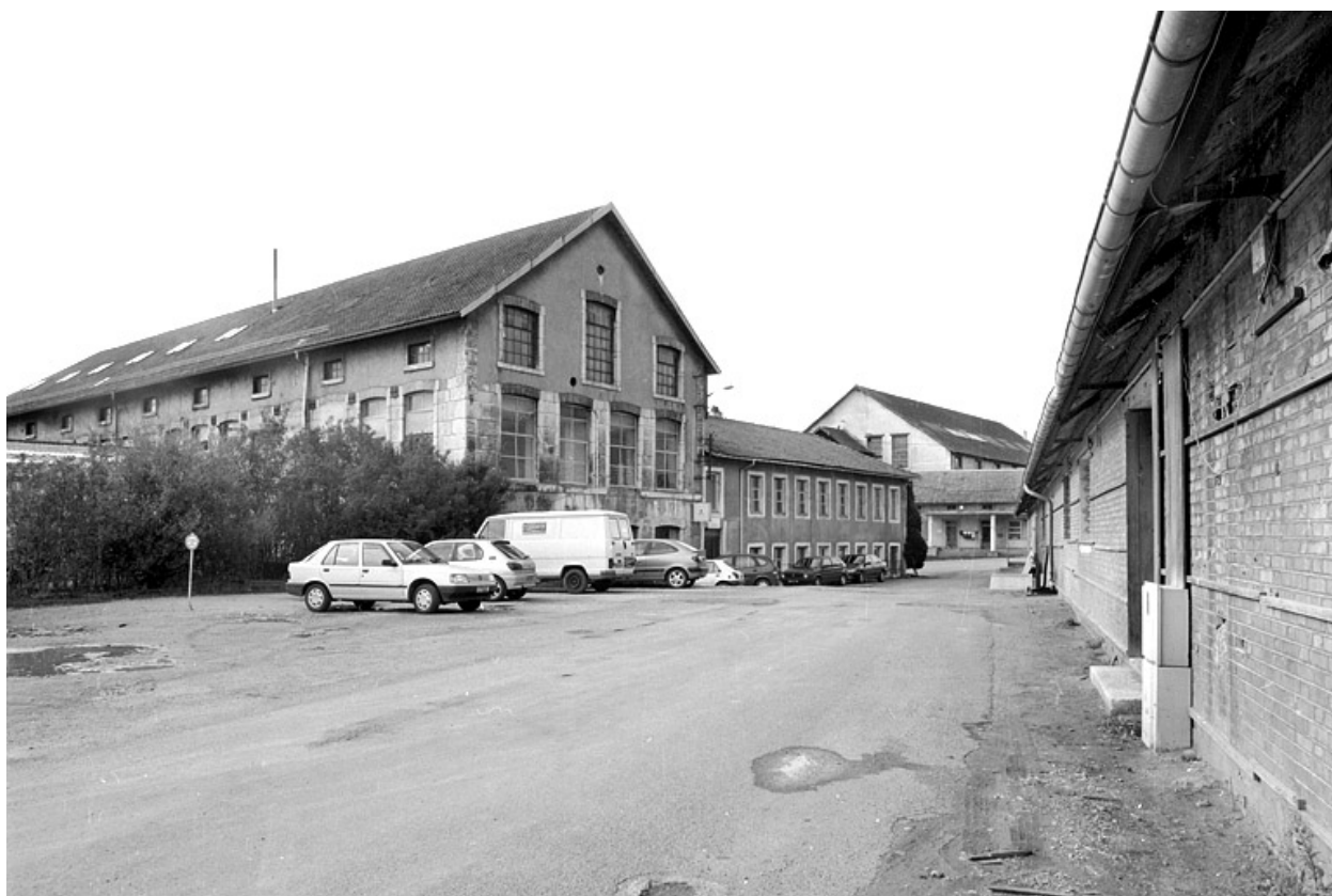
Atelier de fabrication et bureau depuis l'est.
