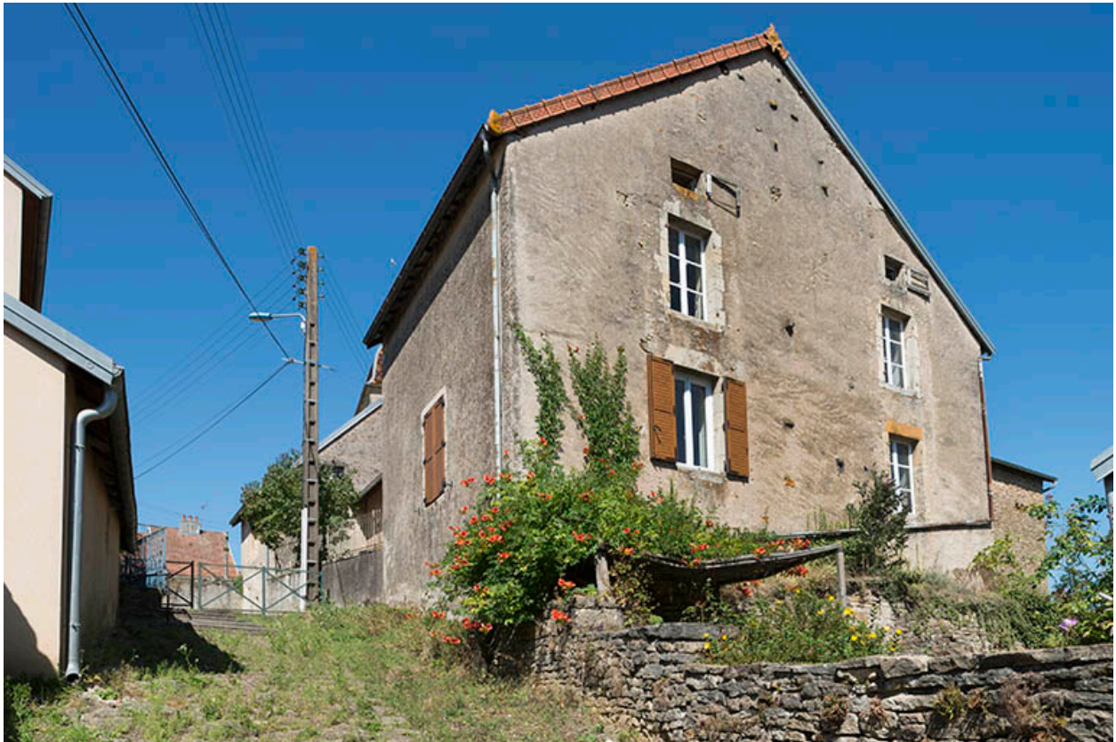
Le mur pignon côté sud.
