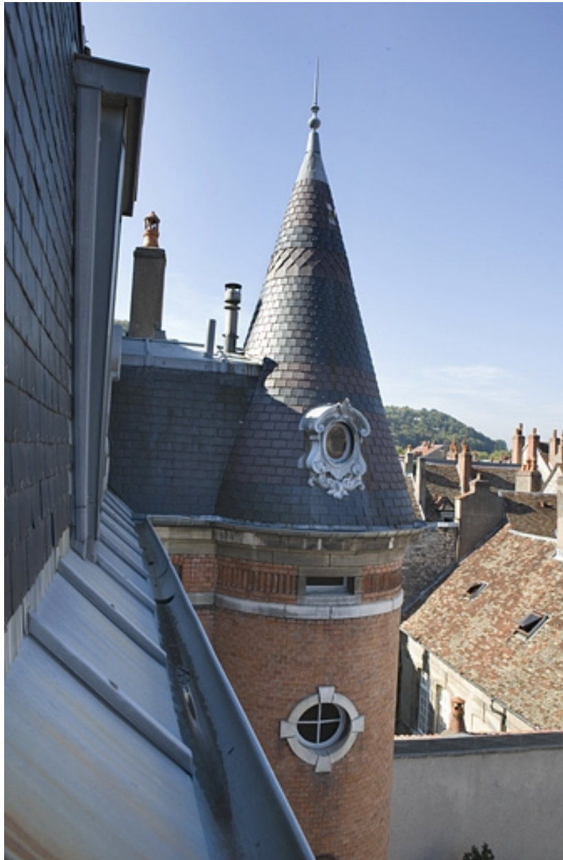
Détail du dernier étage et du toit de la tour d'escalier.
