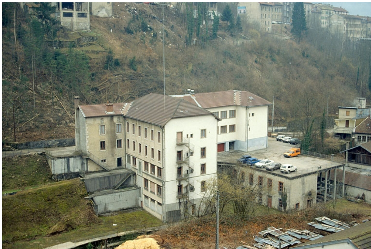
Vue d'ensemble plongeante depuis le nord.
