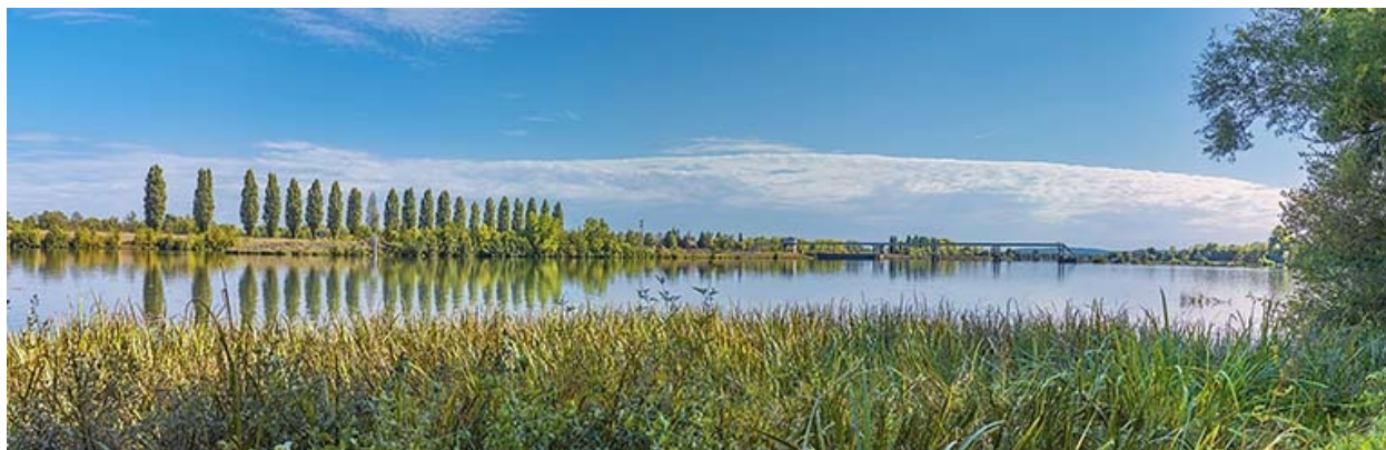
Le barrage, vu d'amont.
