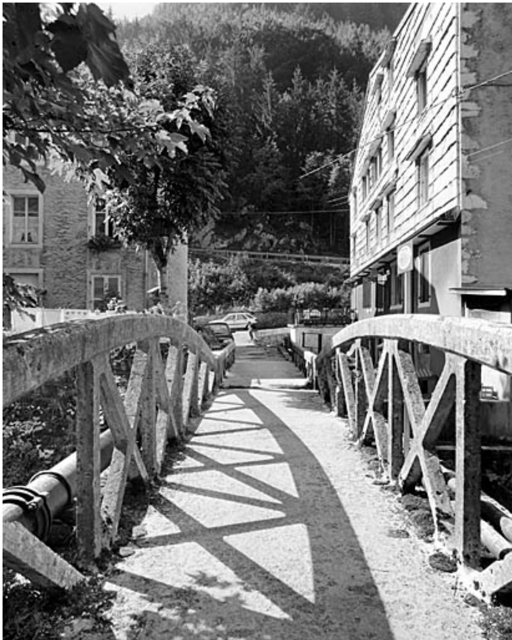
Tablier et garde-corps, depuis la rive droite.
