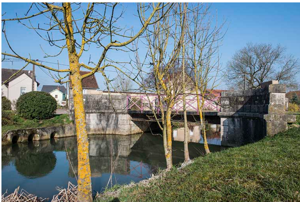
Le pont enjambant le ruisseau.
