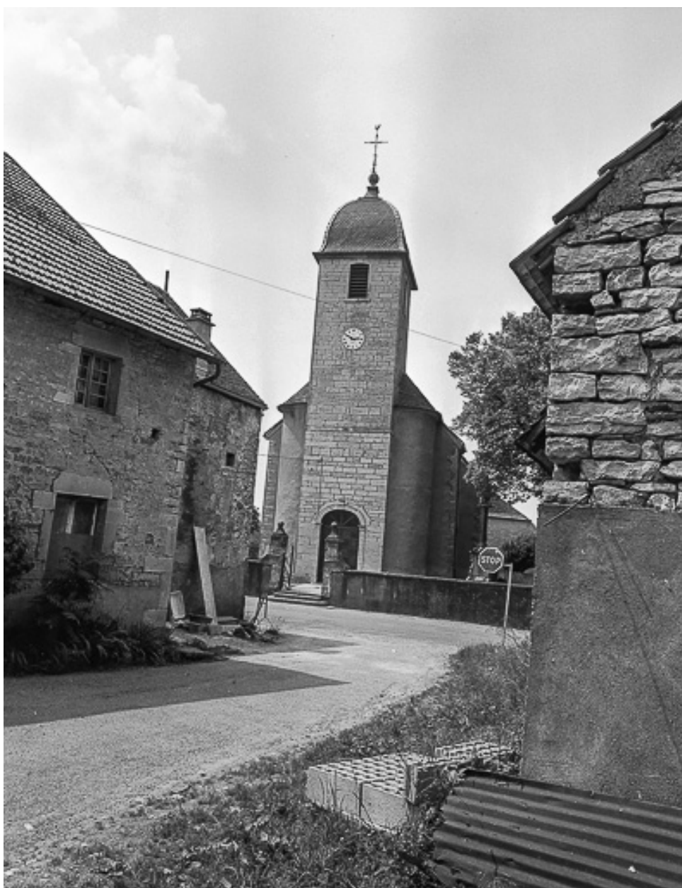
Extérieur : façade antérieure vue éloignée.
