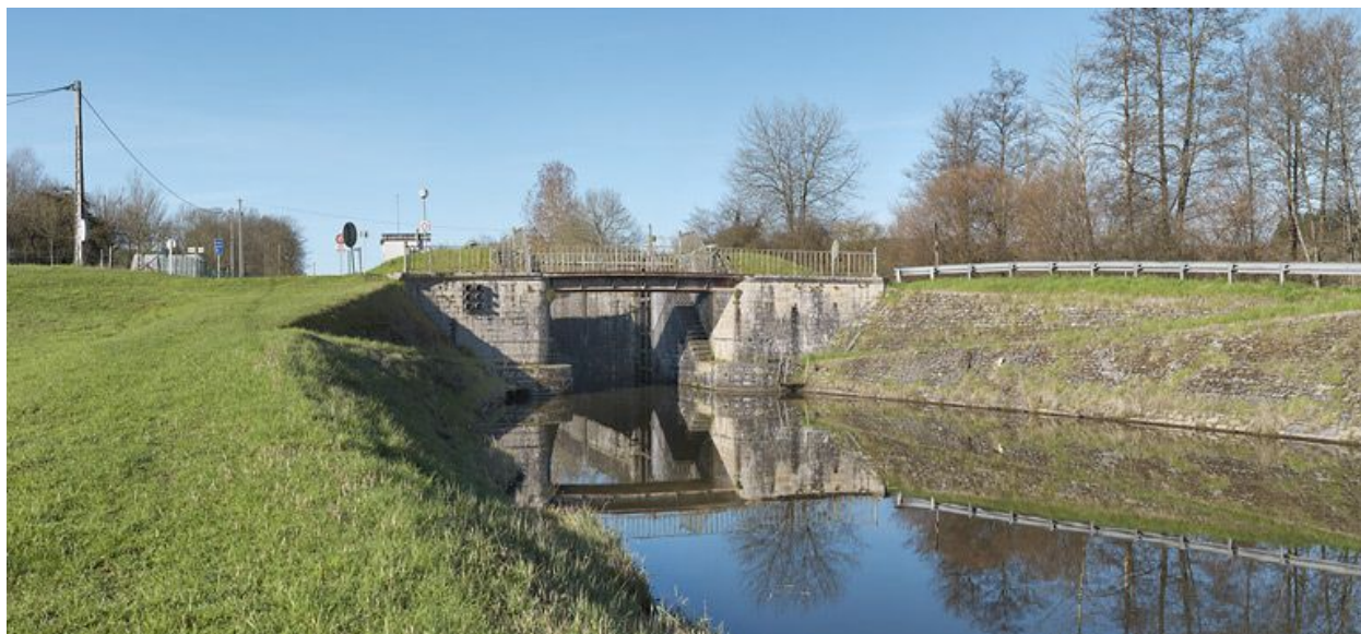
Vue d'ensemble, prise d'aval.
