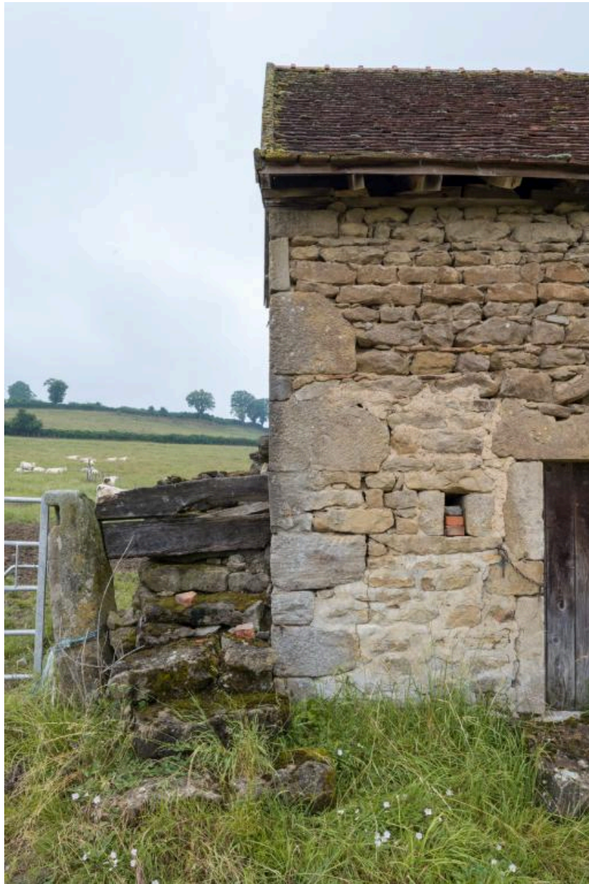
Détail de la dépendance secondaire : escalier permettant l'accès au grenier
