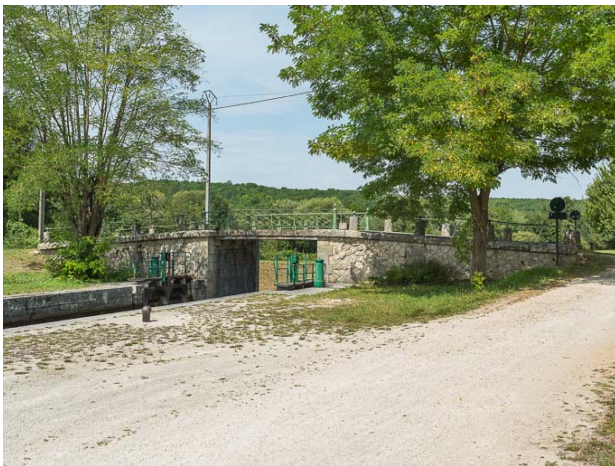
Vue d'ensemble du pont.
