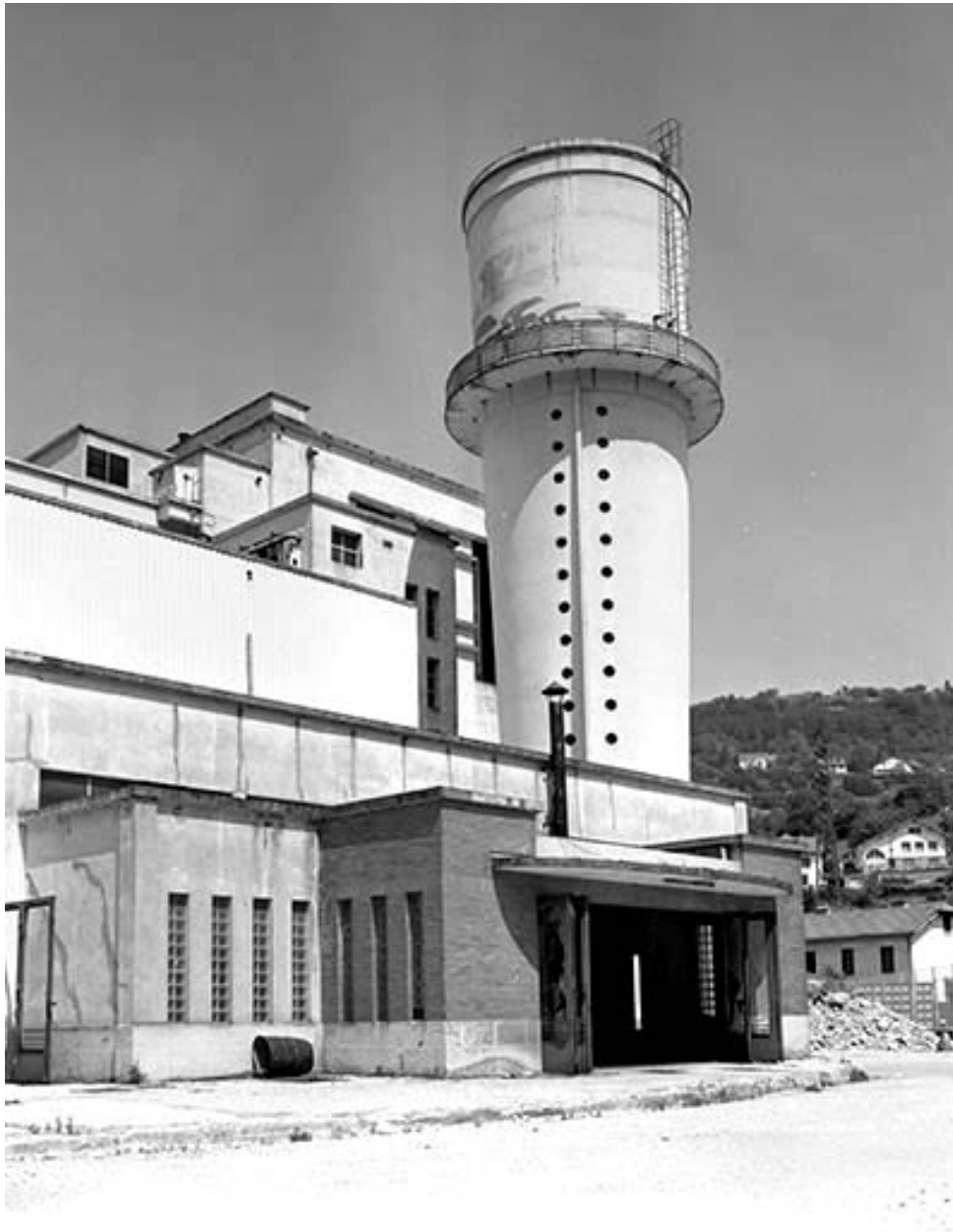
Centrale frigorifique et château d'eau.
