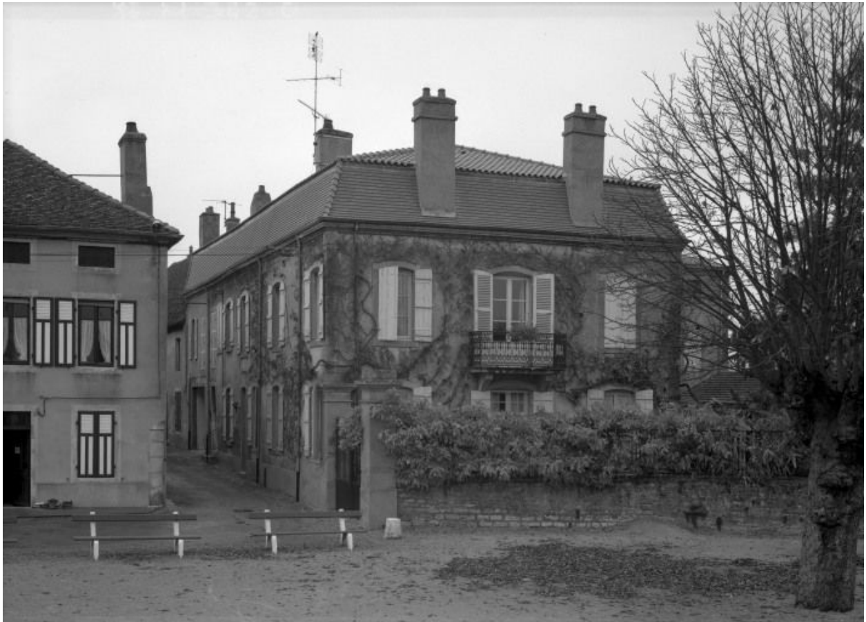
Vue d'ensemble d'une maison (cada. 1977, sect. AD, parc. 228 ; rue du Pignon ; rue du Bac, 9 ).
