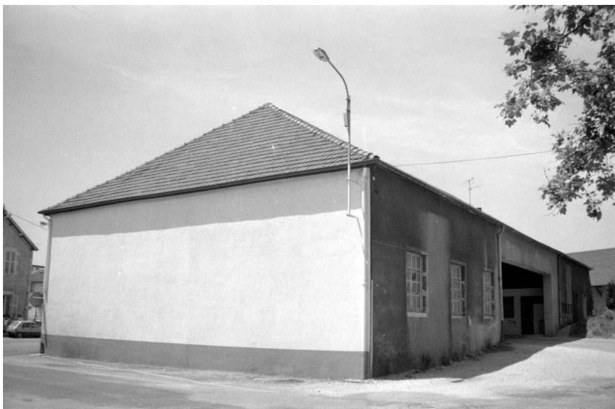
Façades postérieure et latérale droite.
