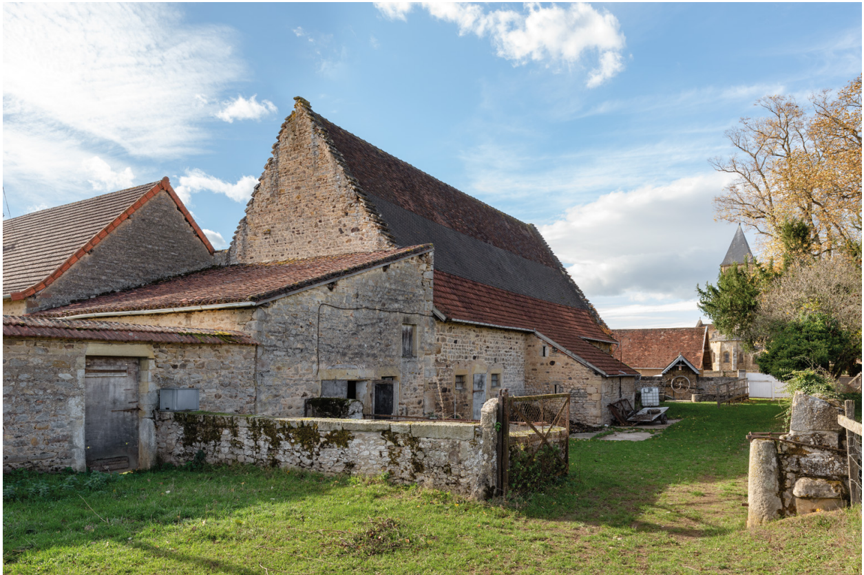
Façades postérieures des bâtiments agricoles.
