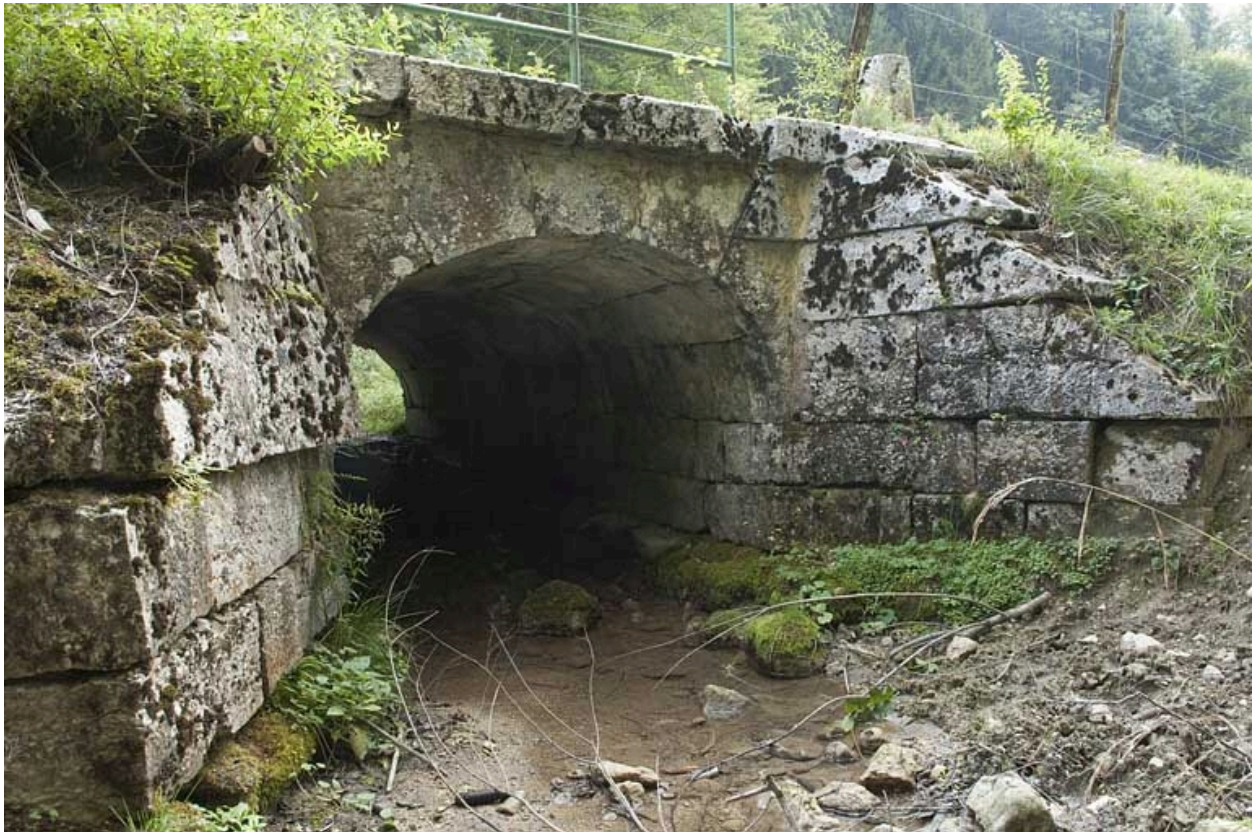
Pont du ruisseau de la Goulette (n° 18), vu depuis l'aval.
