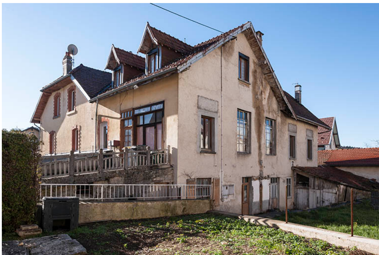
Façades postérieure et latérale droite.
