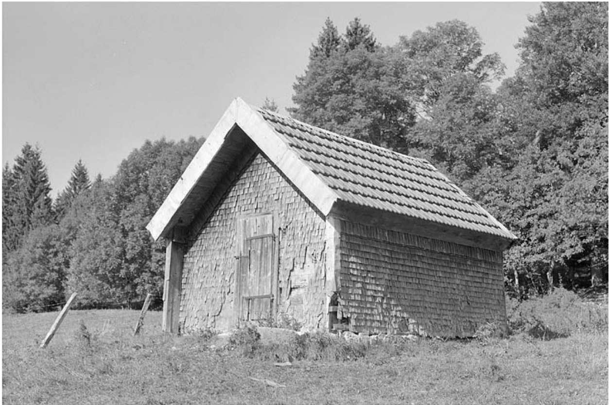
Grenier fort en essentage de bardeaux au lieu-dit la Couronne.
