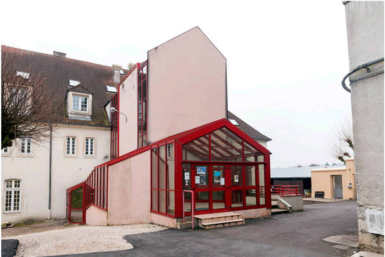
Façade nord-ouest du bâtiment de cantine et internat.
