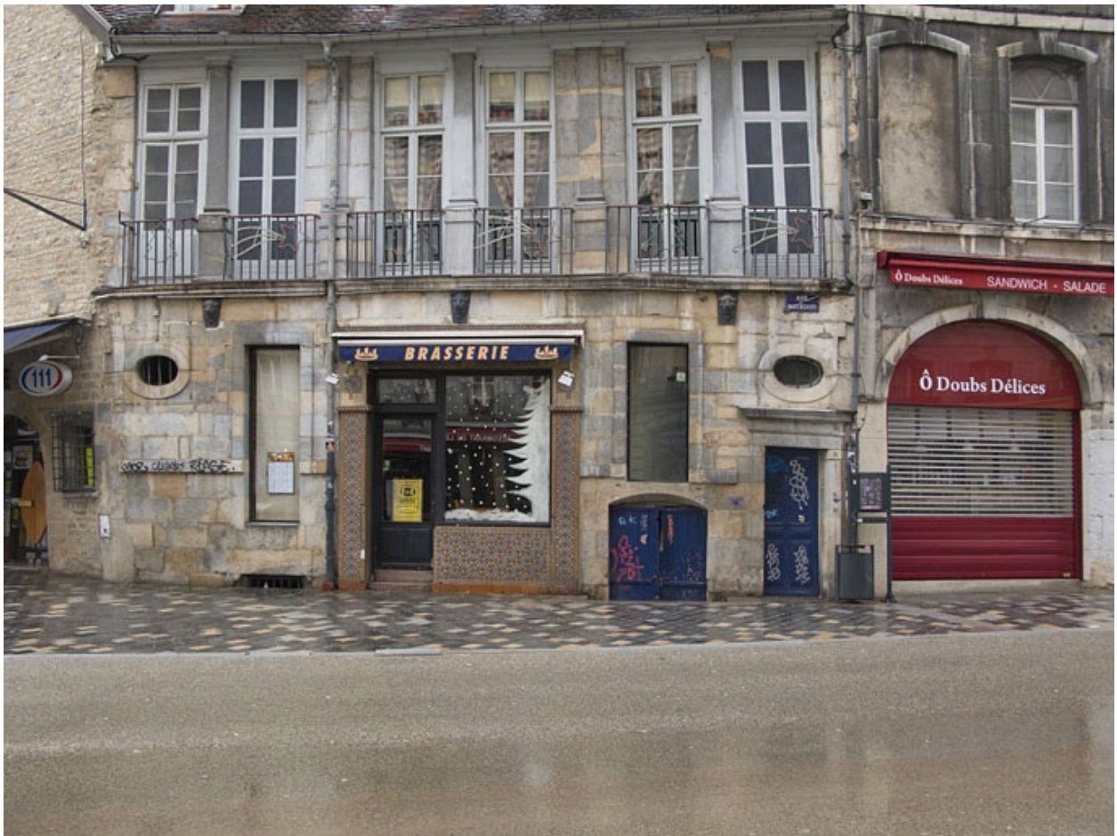
Détail de la façade antérieure du logis secondaire, rue des Boucheries.
