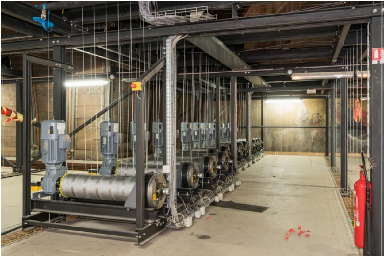
Croisée du transept : cintres du théâtre, avec les moteurs des équipes.
