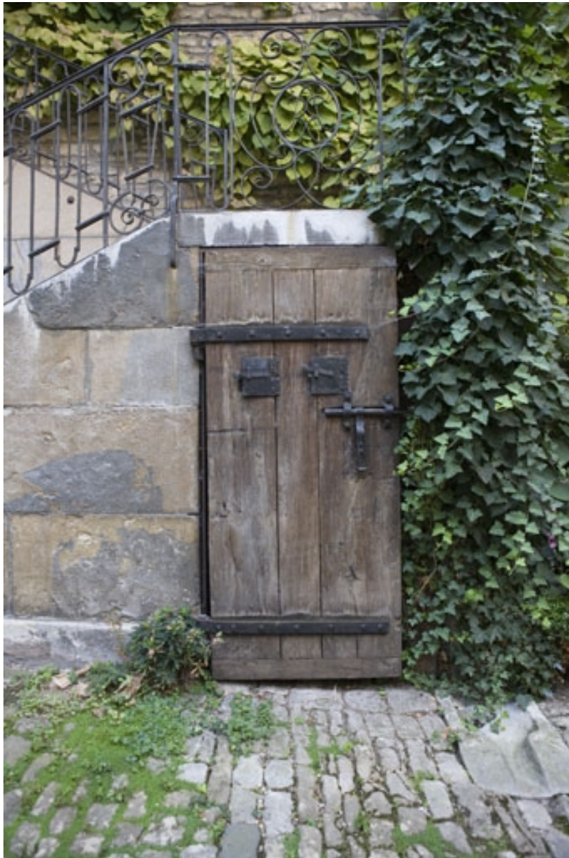
Porte dans le soubassement de l'escalier extérieur : vue d'ensemble.
