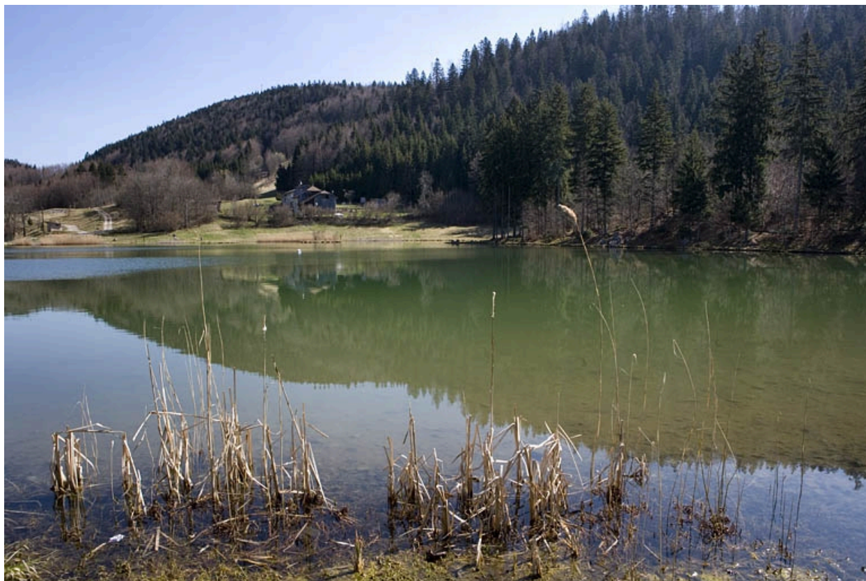
Réservoir : vue d'ensemble, depuis l'ouest.
