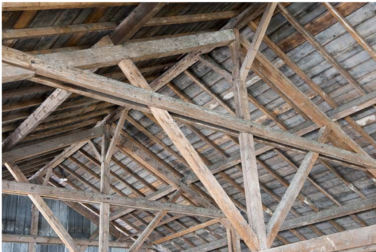
Entrepôt industriel. Détail de la charpente.
