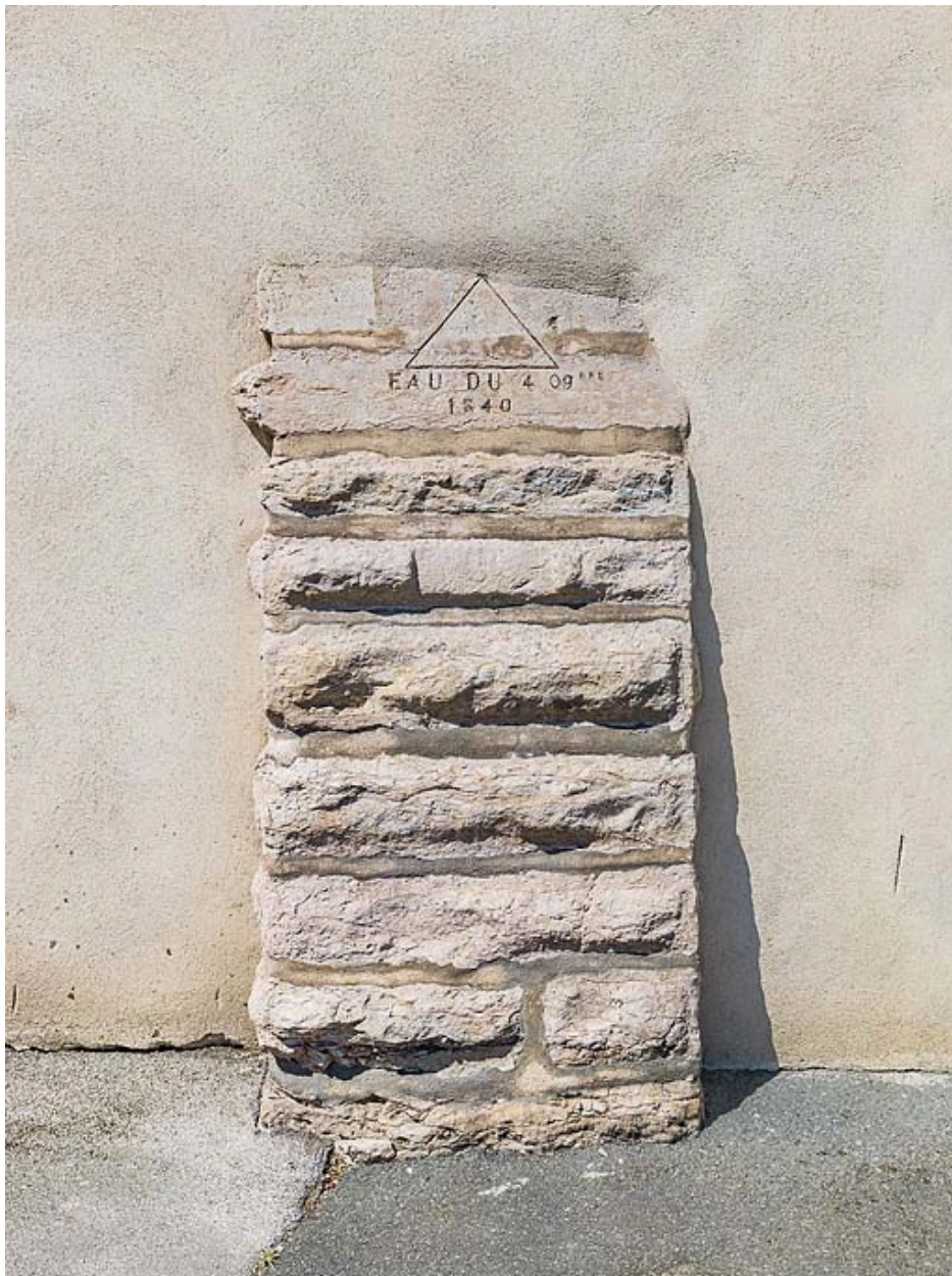
Détail du repère de la crue du 4 novembre 1840 sur une maison quai du Midi.
