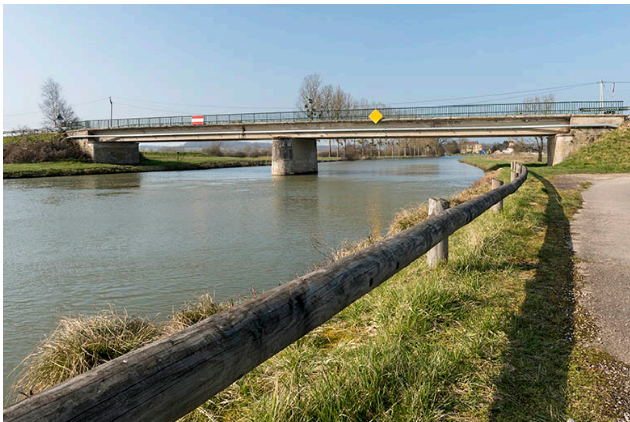
Pont routier franchissant la rivière.
