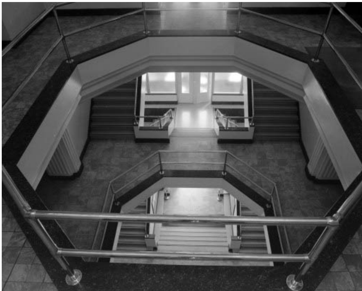
Grands Bureaux : vestibule à l'italienne et escalier.
