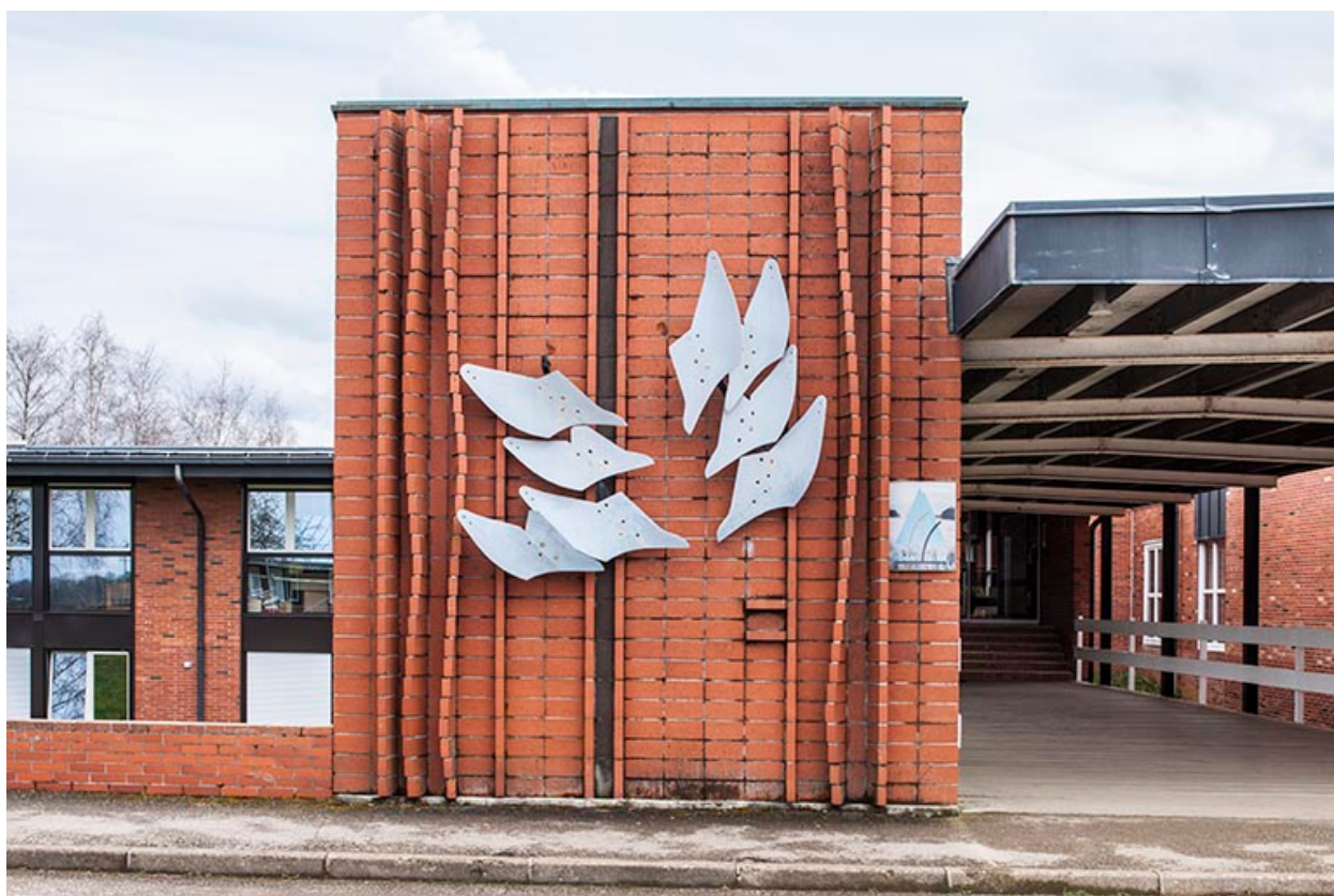
Mur nord vu de face.
