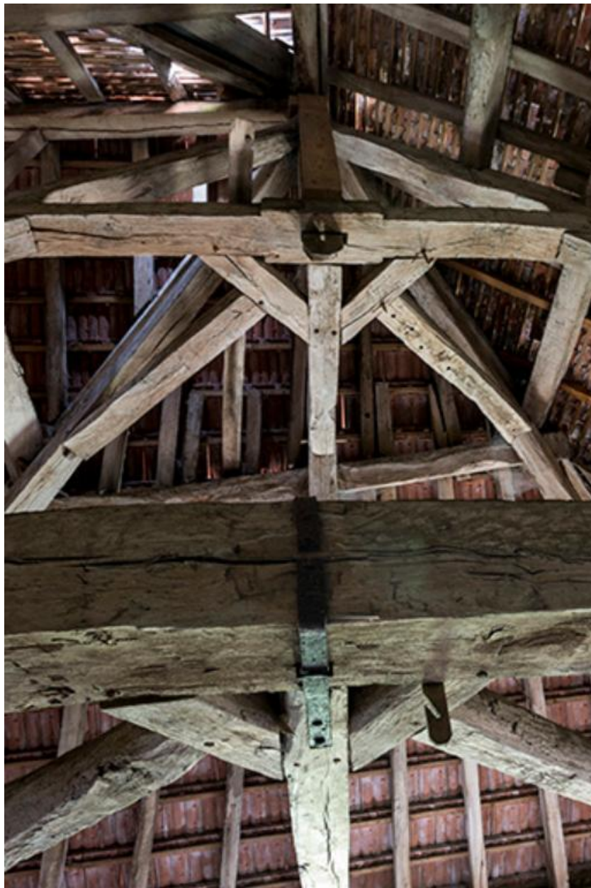
Poutrage du grenier de la chapelle
