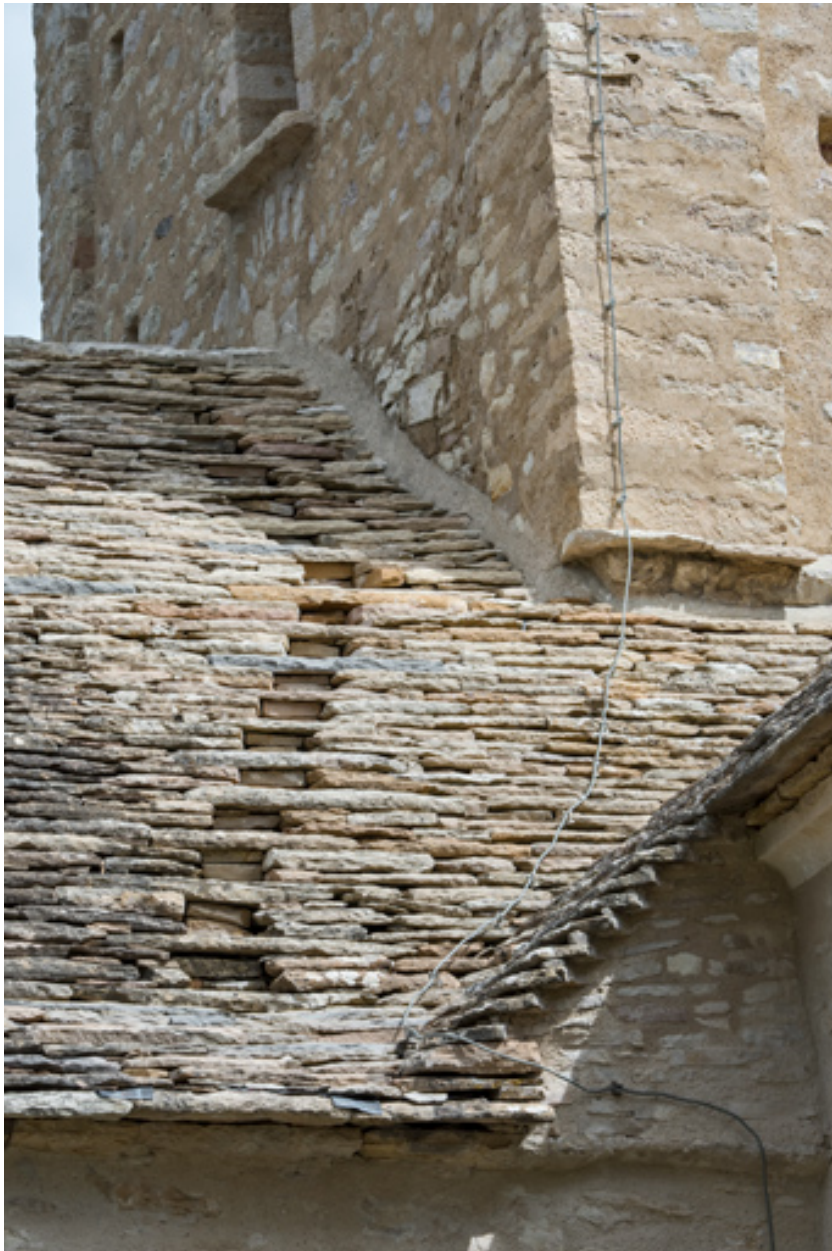
Marches sur le toit de la nef.
