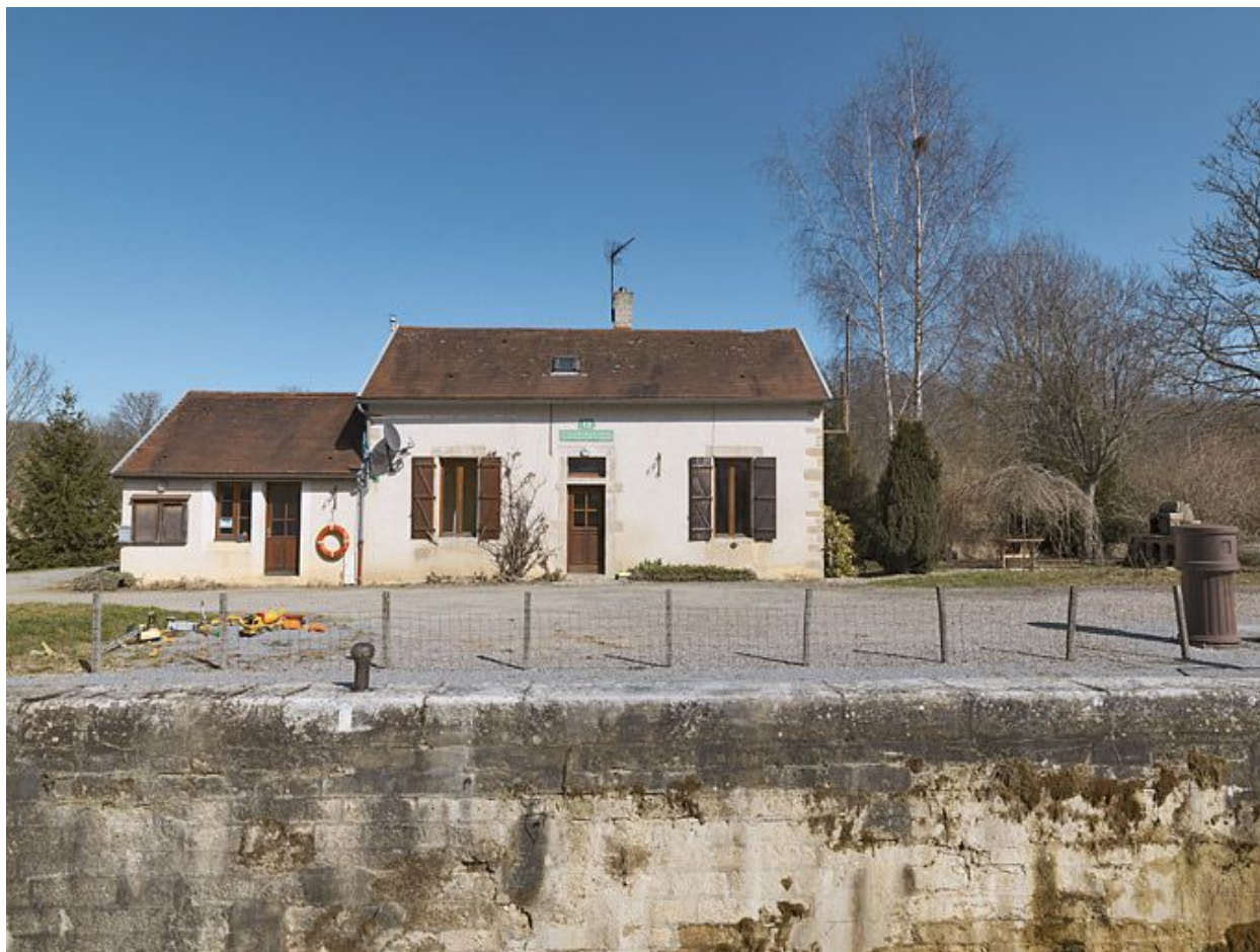
La maison éclusière de face.
