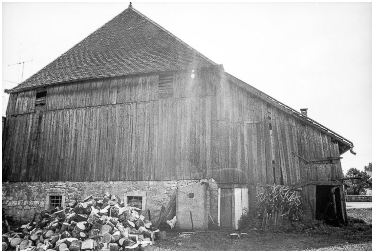
Ferme cadastrée 1962 E 80 : façade latérale (?).
